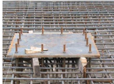
شکل (۱-۹) اجرای کفستون‌ها در پی
